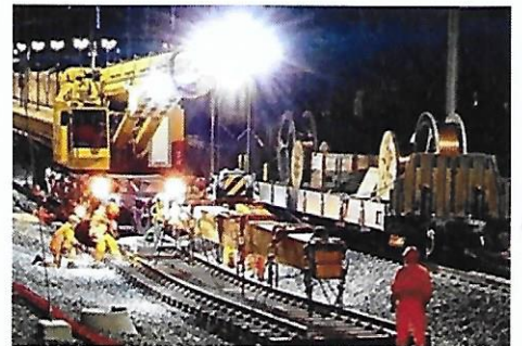
Bei Gleisbauarbeiten ist zeitweise mit grossen Lärmemissionen zu rechnen.
