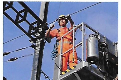
Kabel- und Fahrleitungsarbeiten verursachen mittlere Lärmemissionen.
